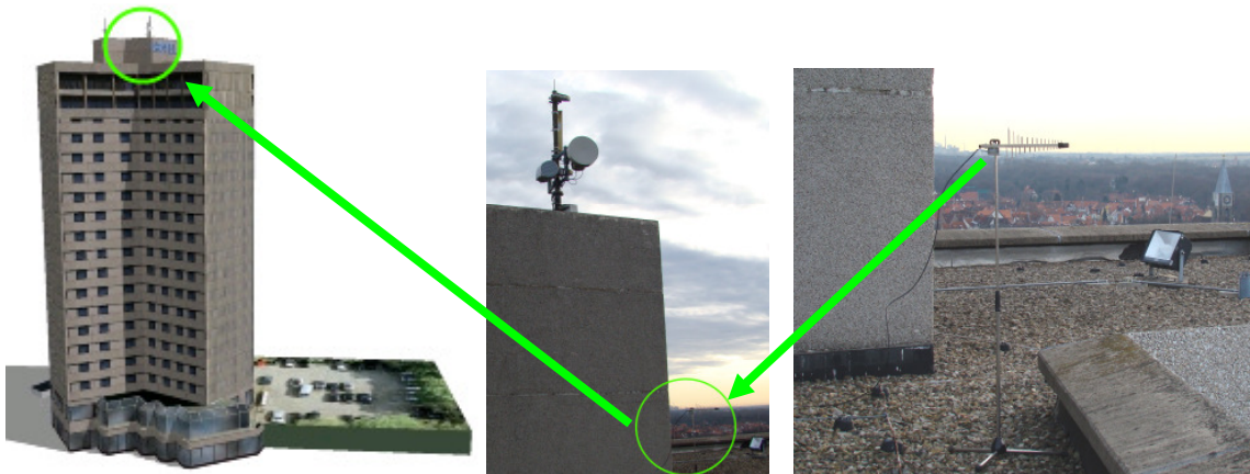
Messantenne im oberen Hotelbereich
