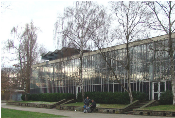
Mobile Messstation vor Glashalle
